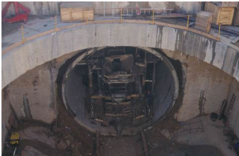
Figura 18: Parte posterior del back-up de la tuneladora vista desde el pozo de ataque, en un tramo de la ampliación de la línea 10. Fotografía del autor.
