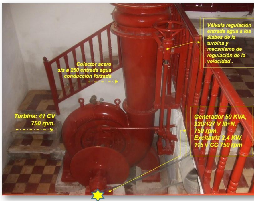
36_Vista real maquinaria grupo II.
