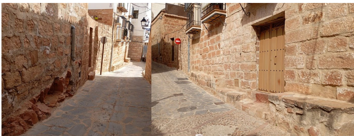
Figura 9. Arenisca en cimiento y poyete del bodegón, calle del Horno
