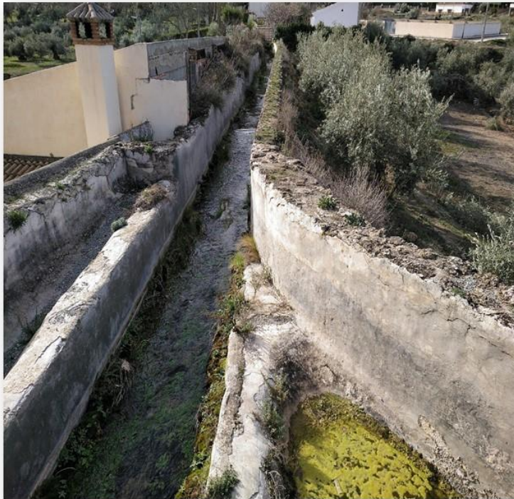
Canal de distribución del agua a la central hidroeléctrica de San Cayetano.
