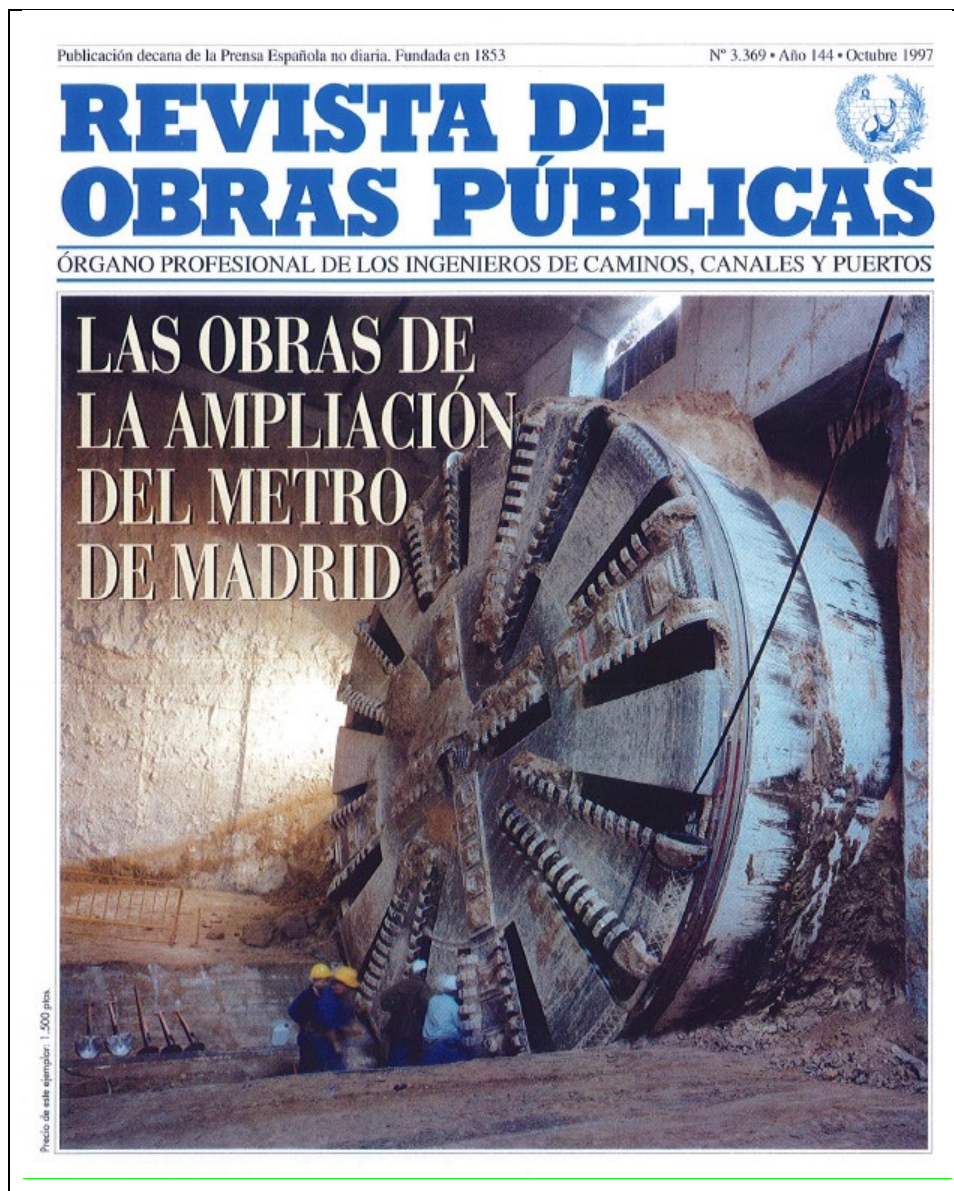
Figura 4: Portada de la Revista de Obras Públicas (ROP) nº3369. Monográfico dedicado a las obras de ampliación del Metro de Madrid entre 1995-1997. Octubre de 1997.
