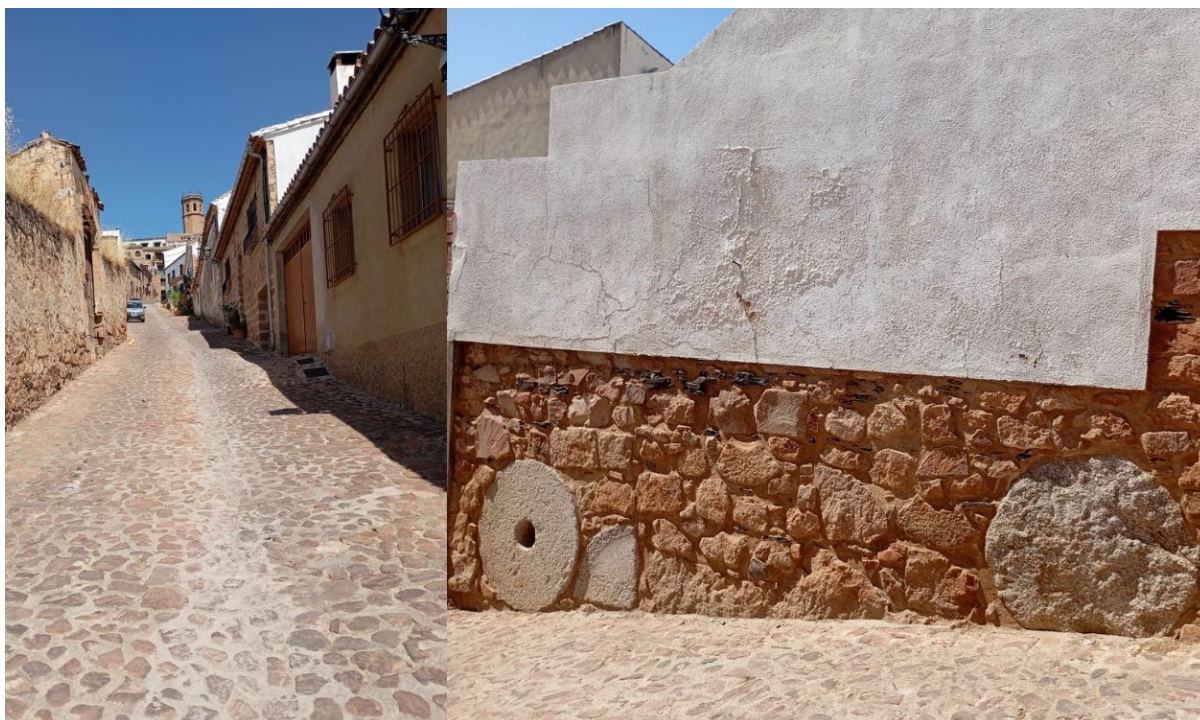
Figura 37. Baja Trinidad y media Trinidad, al fondo la torre campanario de San Mateo. A la derecha, viejas muelas de la almazara cimentando casas de nuevo cuño
