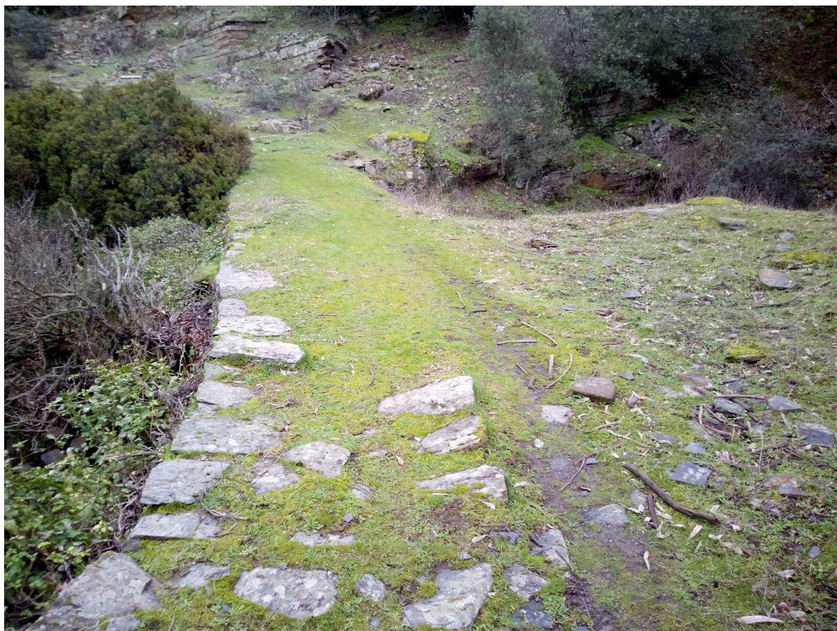
Diapositiva 14: Trazado original de la Carretera de Despeñaperros (y posiblemente del Camino de Olavide) y puente, en el arroyo de la Yedra
