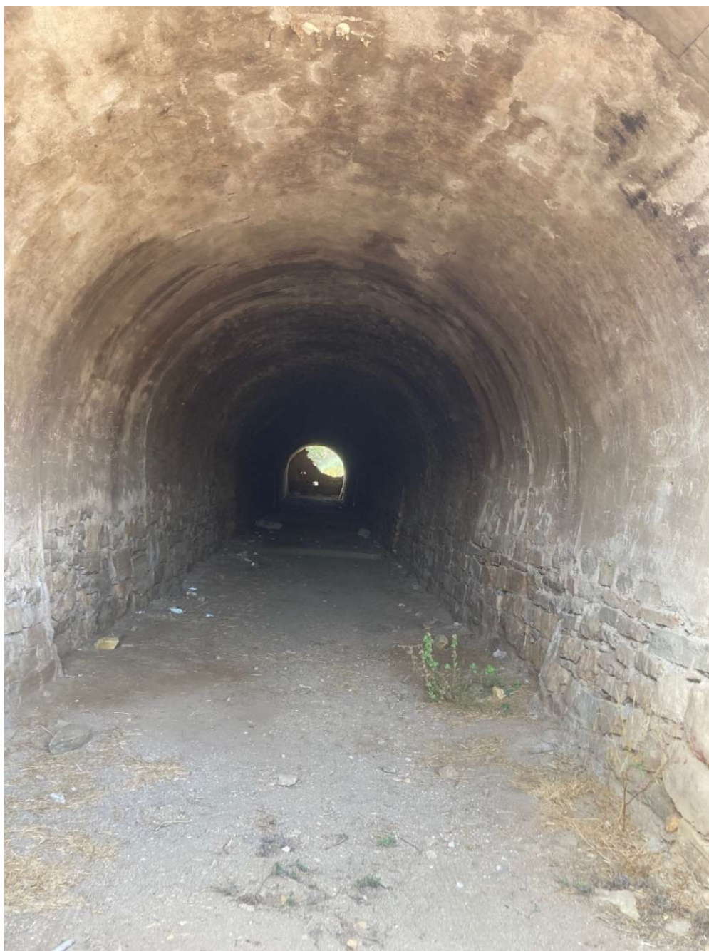
Túnel de la estación de carga de Tres Amigos (2024)
