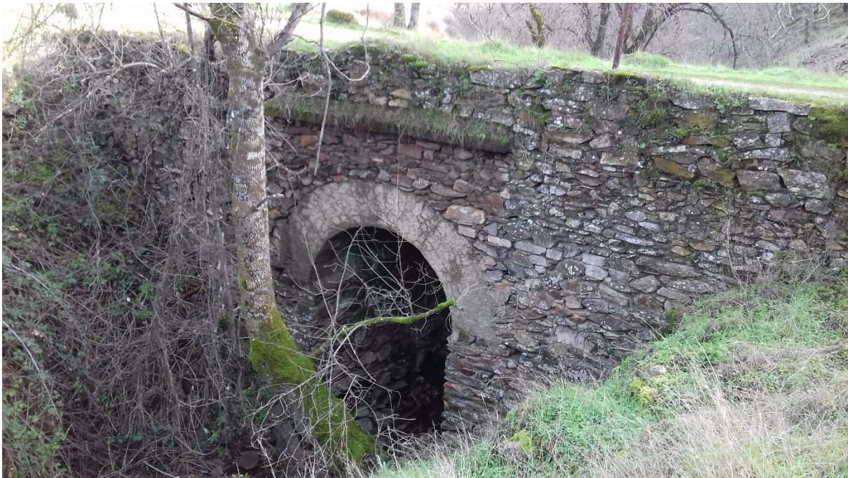
Diapositiva 20. Puente de la vieja carretera de Despeñaperros
