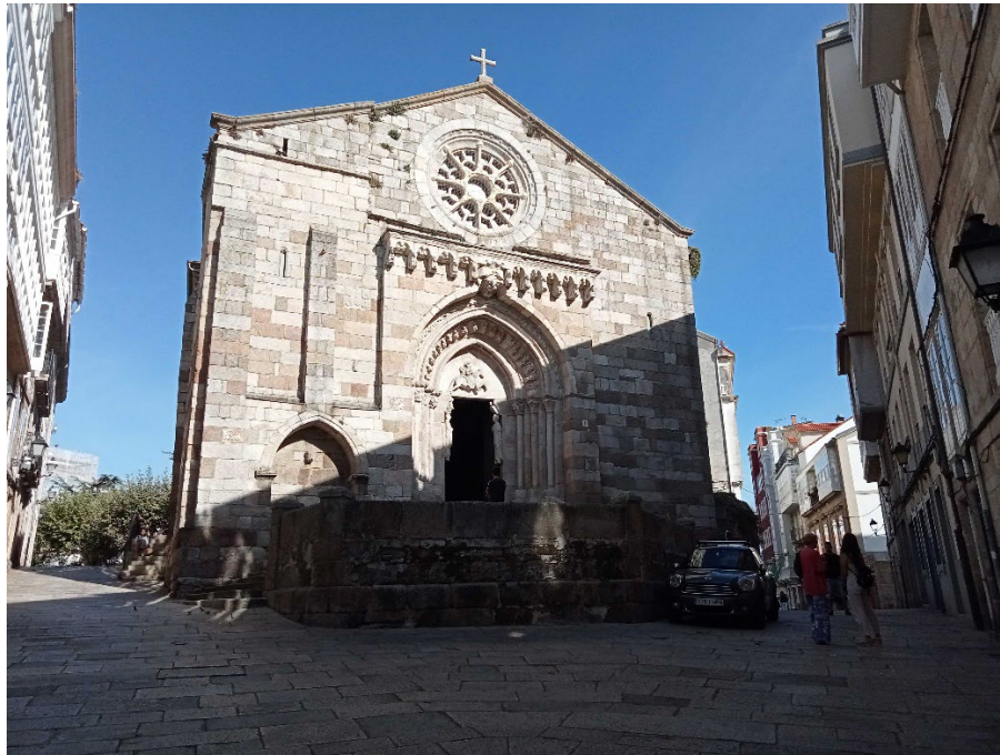
Figura 2: Vista general de la fachada principal de la iglesia de Santiago de A Coruña desde la Calle del Parrote (Fotografía del autor).
