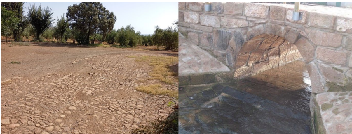
Figura 23. Empedrado en el Camino de Majavieja y puente de Los Charcones
