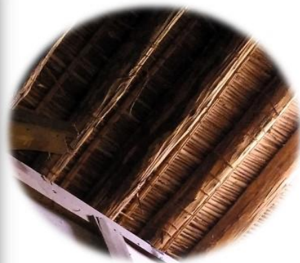
Detalle de la cubierta, construida por vigas y faldones en madera.
