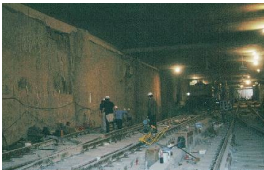
Figura 20: Los visitantes avanzamos sobre la playa de vías para comprobar los trabajos de soldadura de barra larga en los carriles de la estación de Nuevos Ministerios. Fotografía del autor.
