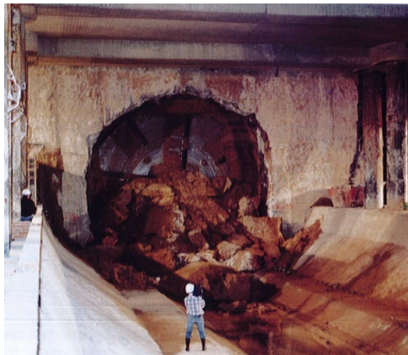
Figura 1: Tuneladora “La Chata” en las obras de ampliación del Metro en 1997. Calado de túnel en la línea 4, tramo Esperanza-Mar de Cristal. Publicada en la ROP [17].
