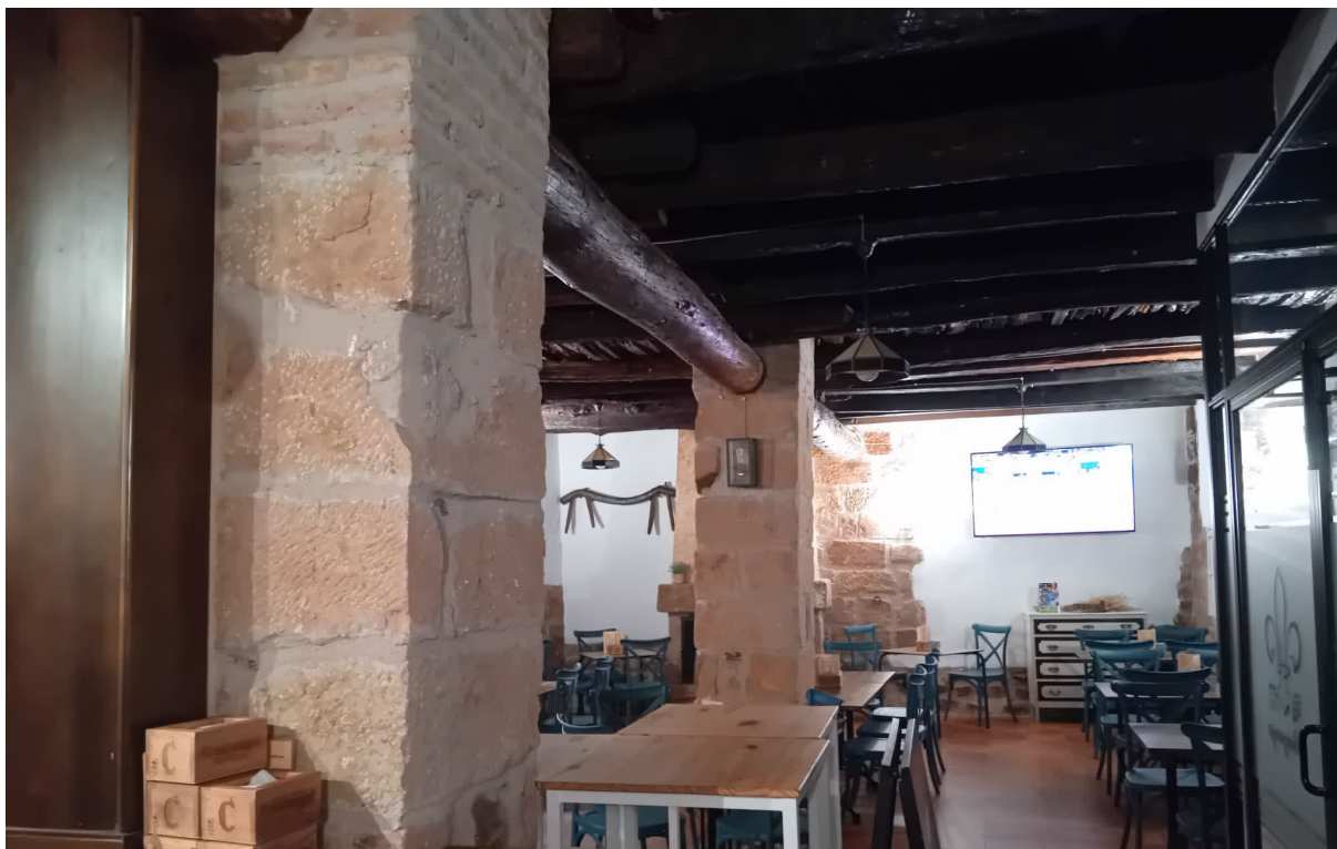
Figura 6. Construcción sustentada sobre muro de carga exteriores, machones intermedios y vigas de madera. Casona en la calle Santa María o del Cueto reformado como restaurante
