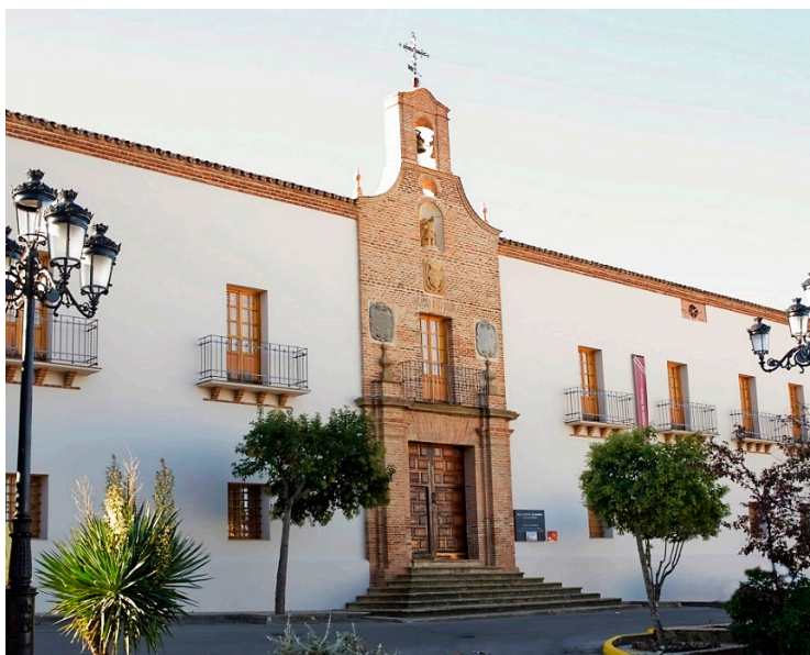
Fig. 8. Fachada principal del Real Hospital de Mineros. Fuente: García Rayo, 2023.
