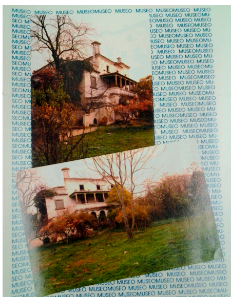
Fig 1. Casa Pedrilla en ruinas antes de ser rehabilitada 22
