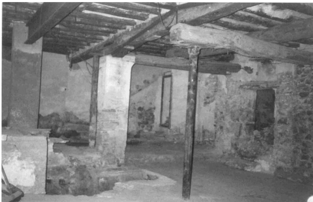
Fig 7. Interior del Caserón de La Fuente de Albarracín durante la rehabilitación.
