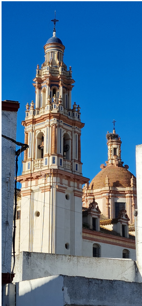
Lám. nº 2. Vista de la torre y cúpula de la iglesia parroquial de San Pedro Apóstol. Fotografía: Antonio Martín Pradas (AMP)
