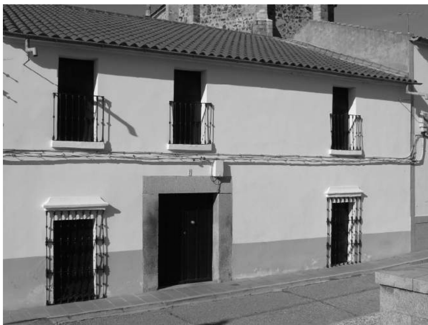
Fig. 8. Fachada de casa tradicional de Medellín.
