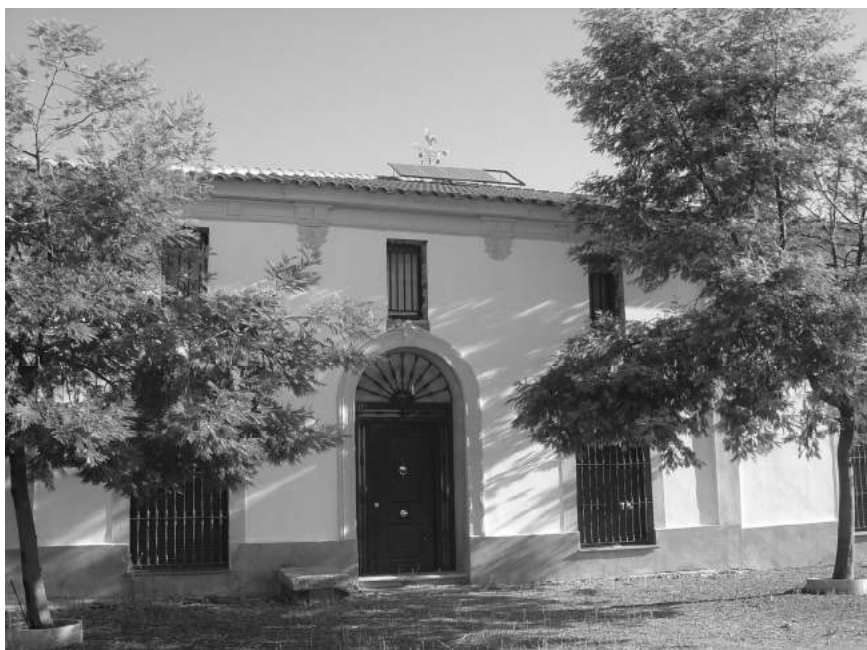
Láms. 3 y 4. Casa nueva de Guadalperal (año 1902).
