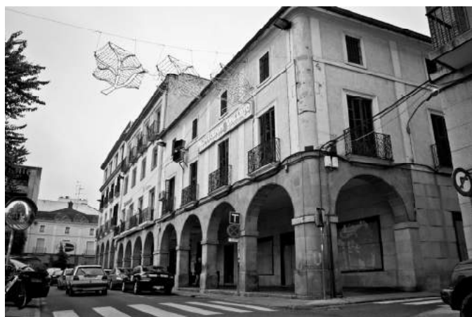
Láms. 4 y 5. Fachada principal y lateral del edificio de la familia Córdova (Fots. Pedro Natalio Rodríguez).
