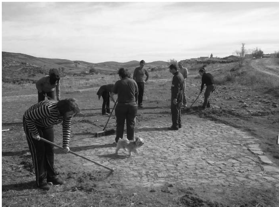
Lám. 10. Inicio de los trabajos de voluntariado para la recuperación de los empedrados.
