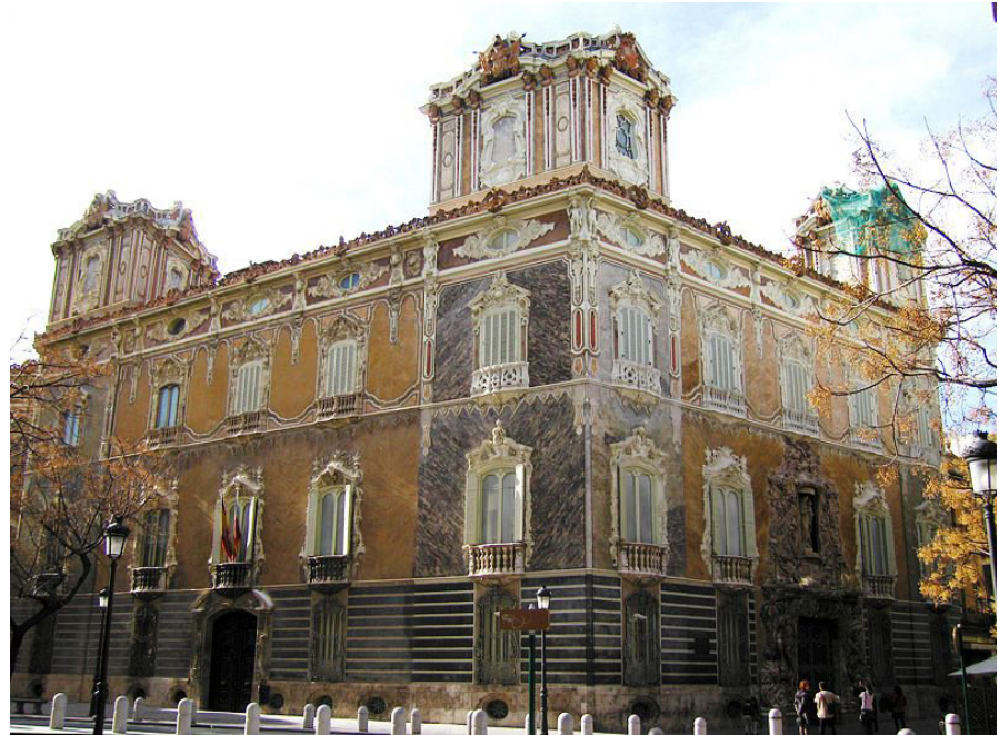
Fachada revestida con yeso, Valencia Fachada revestida com gesso, Valencia Gypsum plaster rendered façade, Valencia
