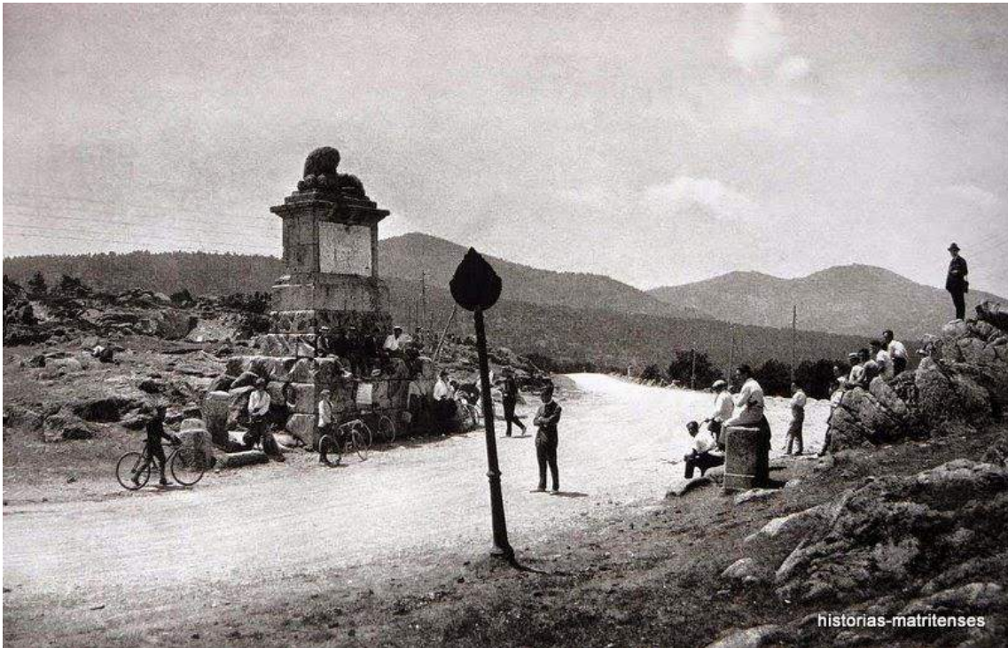
El Alto del León y su monumento. Al fondo la vertiente segoviana, sin Picutos. Aún no está construido el establecimiento de hostelería Casa Hilario.
