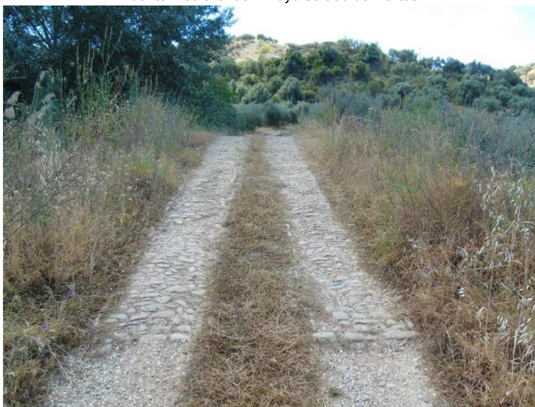
Vía de paso sobre el puente medieval del Arroyo Salado de Martos.
