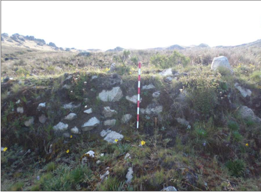
Figura 10 Técnica constructiva correspondiente al caso 4.
