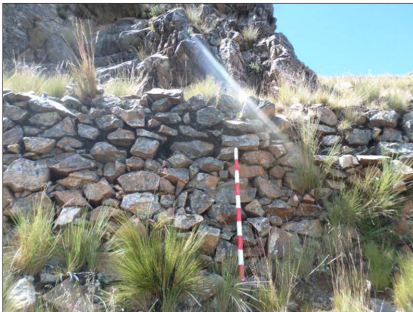
Figura 8. Técnica constructiva correspondiente al caso 2.
