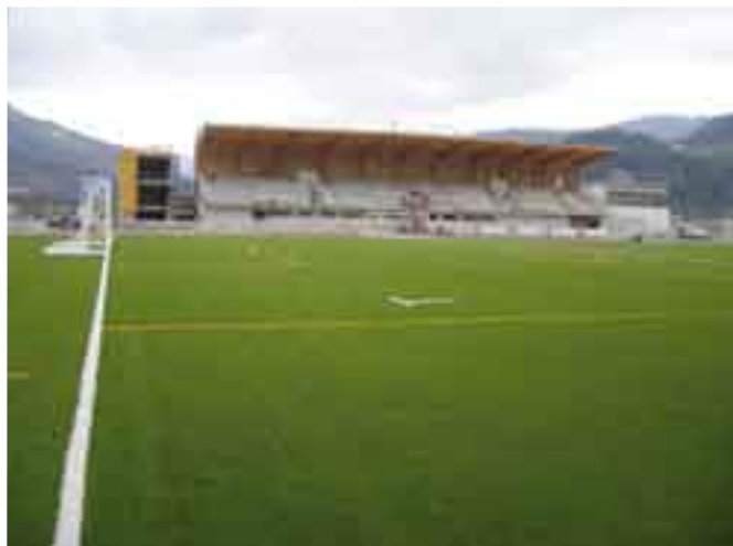
Figura 2. Campo fútbol-rugby instalado.
