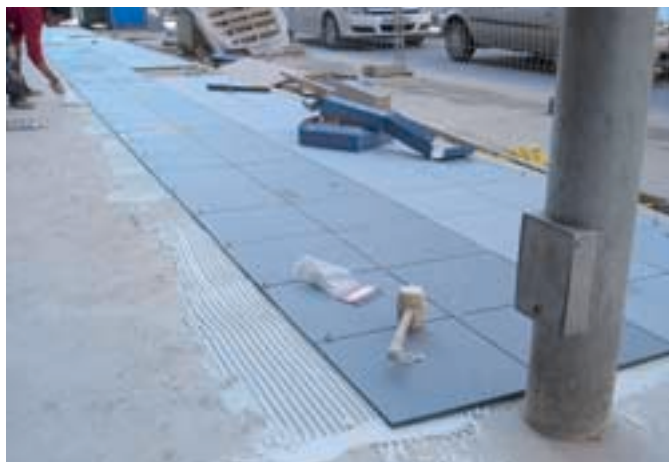
Figura 2. Obra de ejecución e instalación del sistema Civis Agora en la Ronda Mijares de Castellón.
