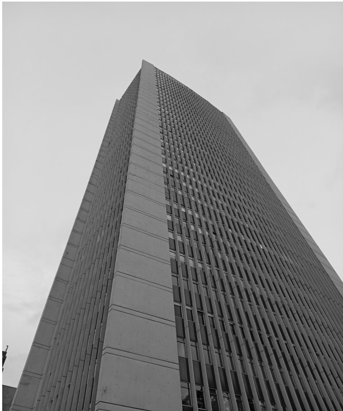
Esta foto tomada desde una perspectiva inferior (en contrapicado) hace que el edificio parezca que tiene una altura inmensa que desde otro plano no se percibiría del mismo modo. Por lo tanto, el enfoque, la perspectiva, es fundamental.
